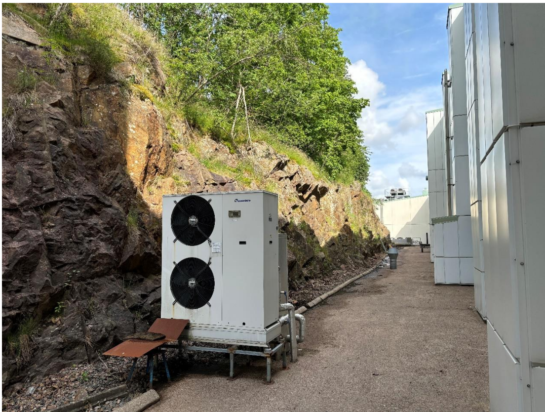
Bild 4 Ovanstående foto visar bergmassa med glesare uppsprickning samt objekt som befinner sig nära bergväggen. Södra delen av bergväggen nedanför planerad nybyggnation.
