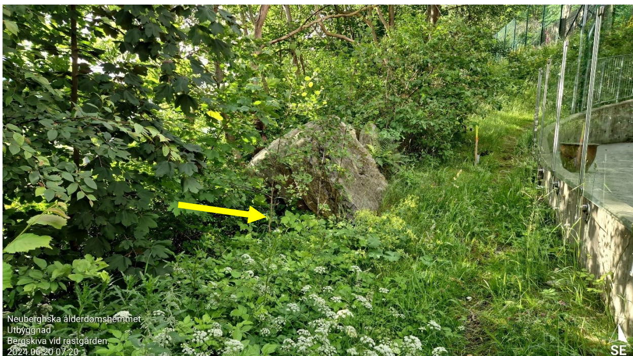
Bild 10 Ovanstående foto visar bergskiva vid rastgården i område B. Markering visar överhängande del. (För position se bild 1).
