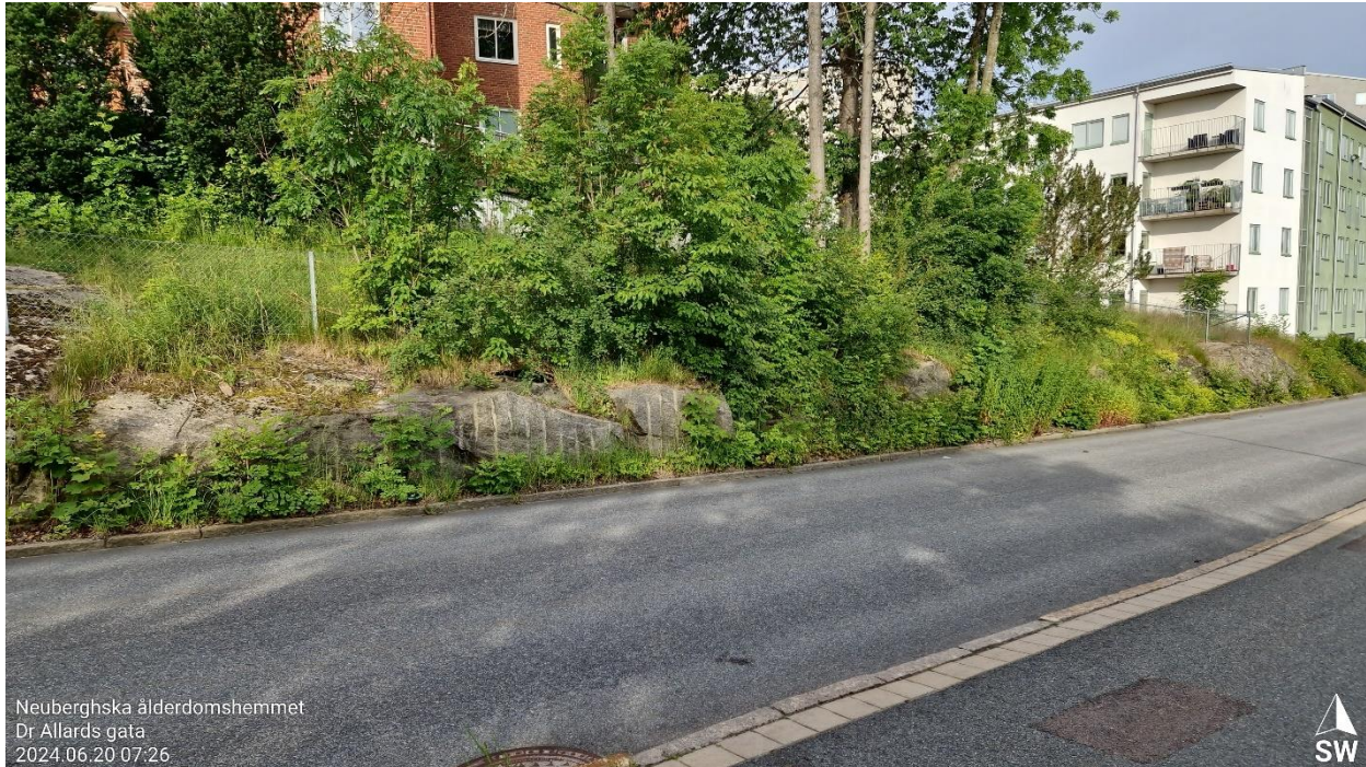
Bild 11 Ovanstående foto visar låg sprängd skärning vid Doktor Allards gata. (För position se bild 1).
