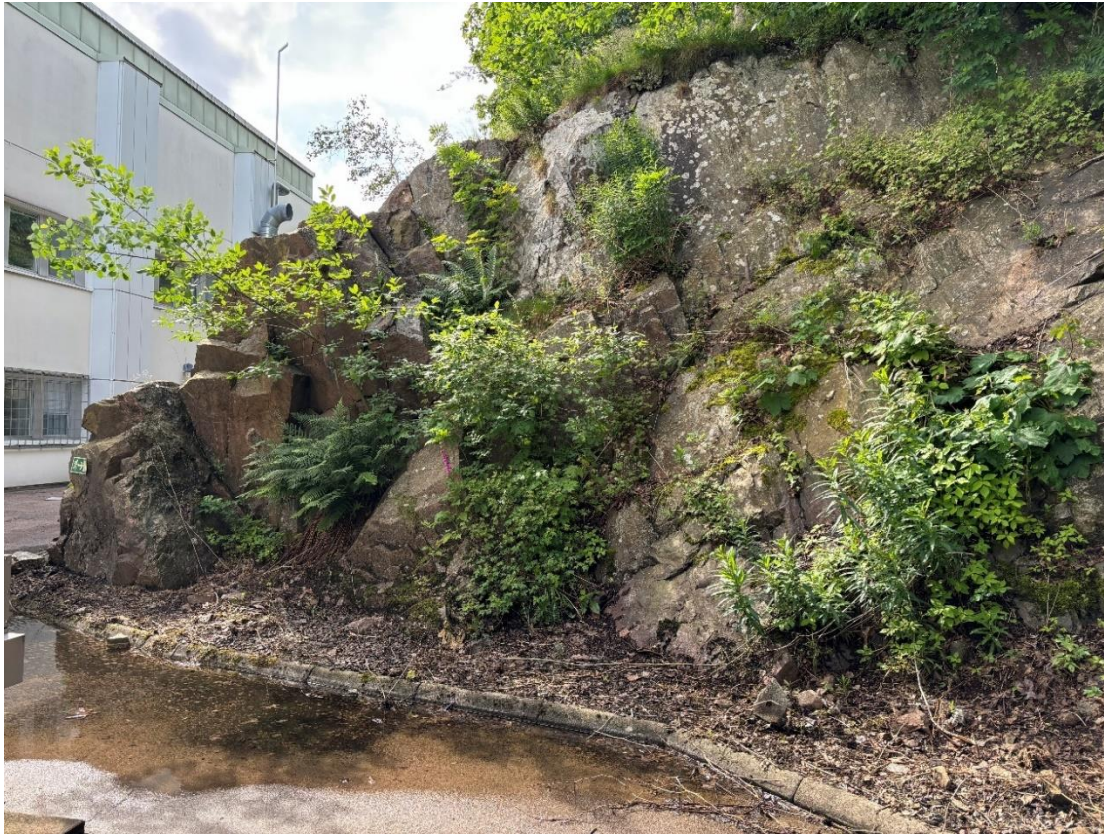
Bild 3 Ovanstående foto visar vegetation i bergväggen som i sig ger risk för rotsprängning av enskilda block eller skivor. Mittre delen av bergväggen.
